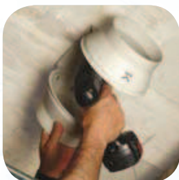
Fissaggio del supporto
